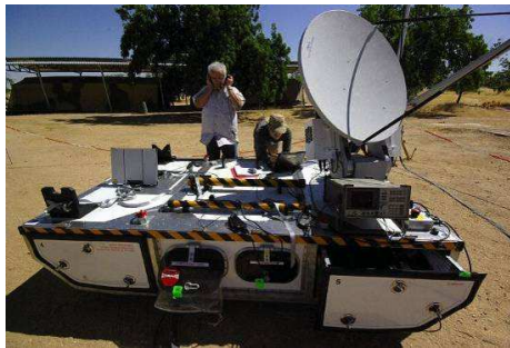
El Emergesat desplegado: telecomunicaciones para la misión humanitaria en Haití
